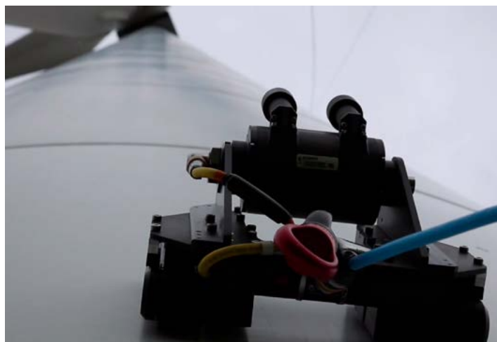
Дистанционный визуальный осмотр ветровой турбины
